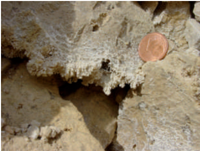
Abb. 27: Durch Tropfwasser angehäufte und teilweise sekundär durch \text{CaCO}_3 verbackene Lublinitfasern auf locker gepackten Steinbrocken aus der Unteren Süßwassermolasse. Der Aufschluss entstand beim Wegräumen der Erde und der obersten Steinlagen im oberen Bereich des Herrlinger Kalksteinbruchs (Fa. Märker-Kalk).
