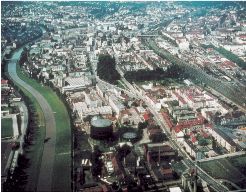
Abb. 11: Die Kernstadt von Pforzheim. Die Enz ist durch die links hinten mündende Nagold mehr als verdoppelt und krümmt sich sanft mit 650 m Radius (Luftbild Muuss Oktober 1969, Blick WSW).
