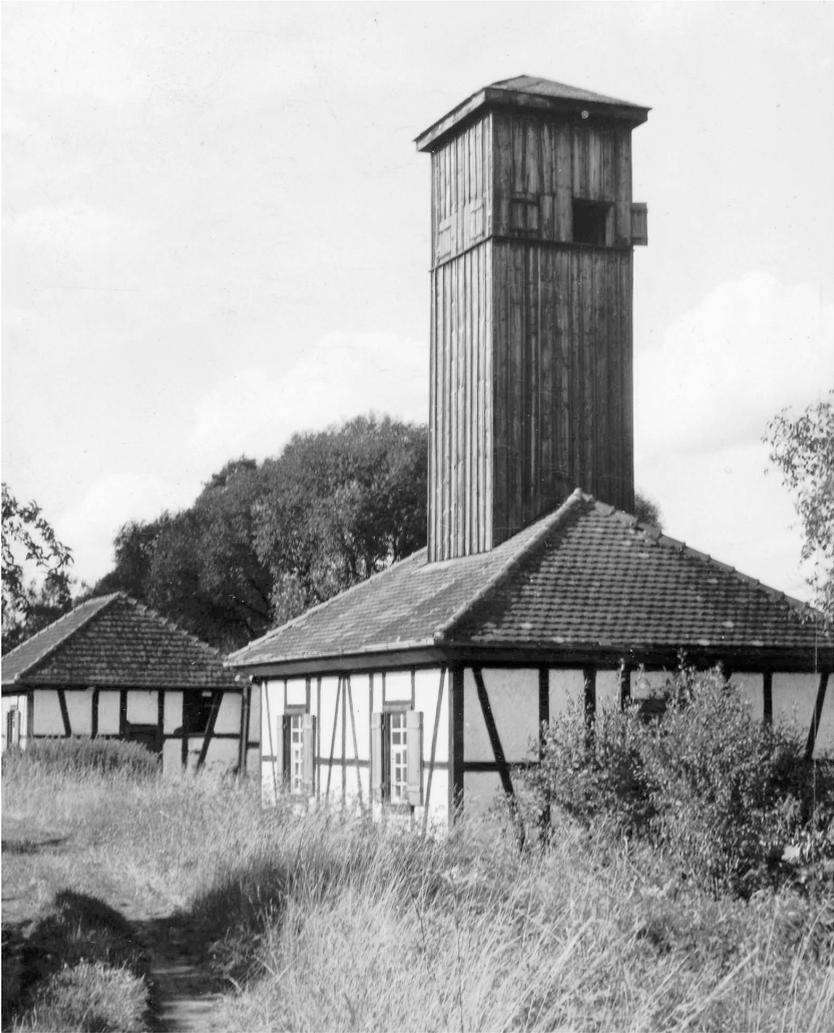
**Abb. 8.** Oberes Bohrhaus, Foto aus dem Jahr 1969, von Westen aufgenommen. Rechts Bohrhaus mit Förderturm der Solebohrung 10, links Rest des Bohrhauses der Solebohrungen 1 und 2. Der Förderturm über der Bohrung 10 wurde nach Einstellung des Betriebs abgebaut. (Foto: W.A. WURST, Quelle: Stadtarchiv Rottweil).
