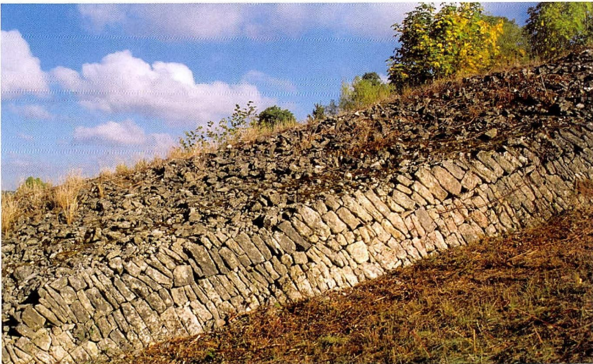
Abb. 10: Eine Besonderheit mancher Steinriegel im Raum Creglingen sind die randlichen Trockenmauern, die einst angelegt wurden, um die Nutzfläche möglichst groß zu halten.
