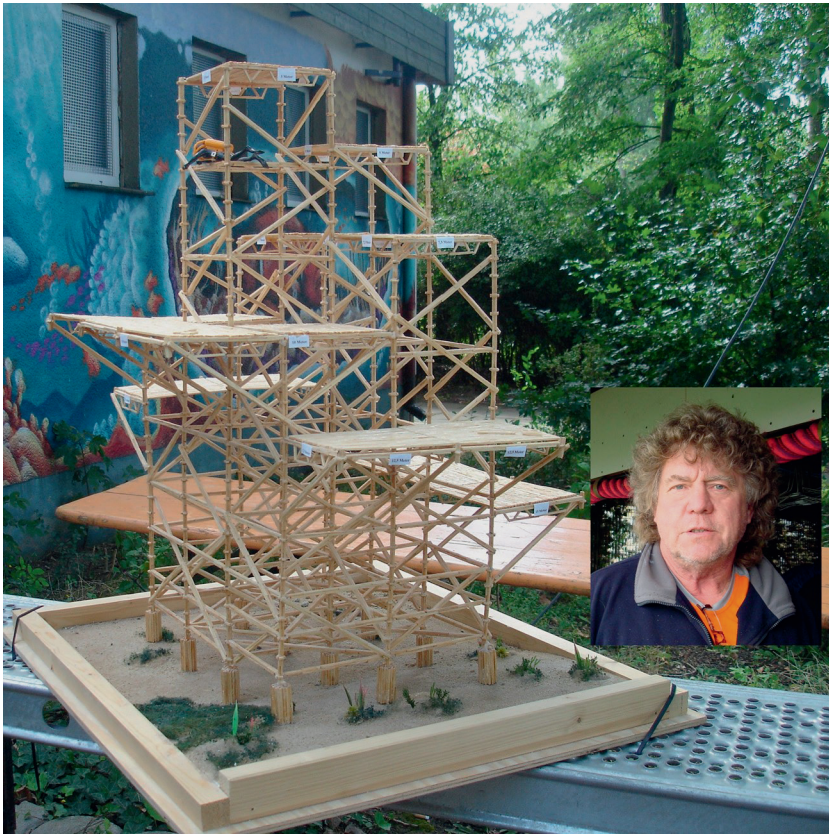
Abb. 8: Modell einer großen UW-Plattform mit mehreren Auslegern zur Ausbildung von Tauchern; tatsächliche Höhe 16 m (vgl. Abb. 2 , H13-14). Diese Plattformen haben sich mittlerweile durch das Einbringen von Reisig und Astwerk zu „künstlichen Riffen“ für die Fischfauna und das sessile Makrozoobenthos entwickelt. Kleines Bild: Tauchbasisleiter REINHARD GRÄFE, der diese Bauprojekte zusammen mit der „Technikgruppe“ des TSV Leipziger Delphine e.V. im Kulkwitzer See realisiert hat.
